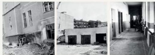
Ремонт перед відкриттям технікуму у 1986 р.
