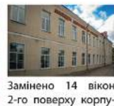
Замінено 14 вікон 2-го поверху корпусу №1.
